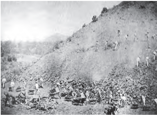
Foto 5. Trabajos en la inmensa mole solar (Batres, 1906).
