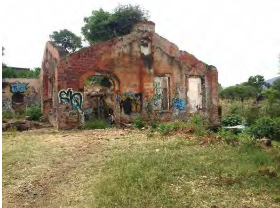
Figura 4: El casco de la hidroeléctrica Vedruzco, Jacona. Fotografía: Lucie Crespo Stupková.
