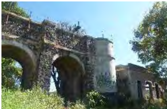
Foto 10. Planta hidroeléctrica de San Francisco de Rizo. Foto: Alberto Aguirre, 2017.
