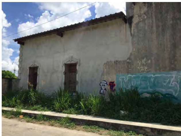
Figura 12. Parte de la restauración de la ex estación de Conkal. Fotografía: Ricardo Manuel Wan Moguel, 2019.
