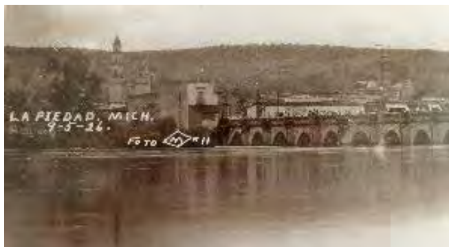
Foto 8. Puente Cabadas tomada el 9 de Mayo de 1926, disponible en la web.
