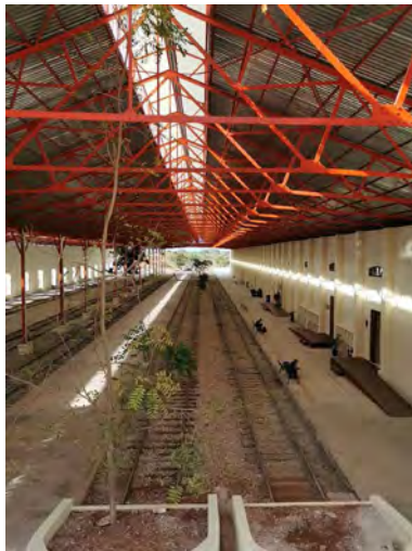
Figura 6. Restauración de los andenes, ex estación de Mérida, 2020. Fotografía Ricardo Manuel Wan Moguel
